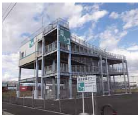
【津波避難タワー】
